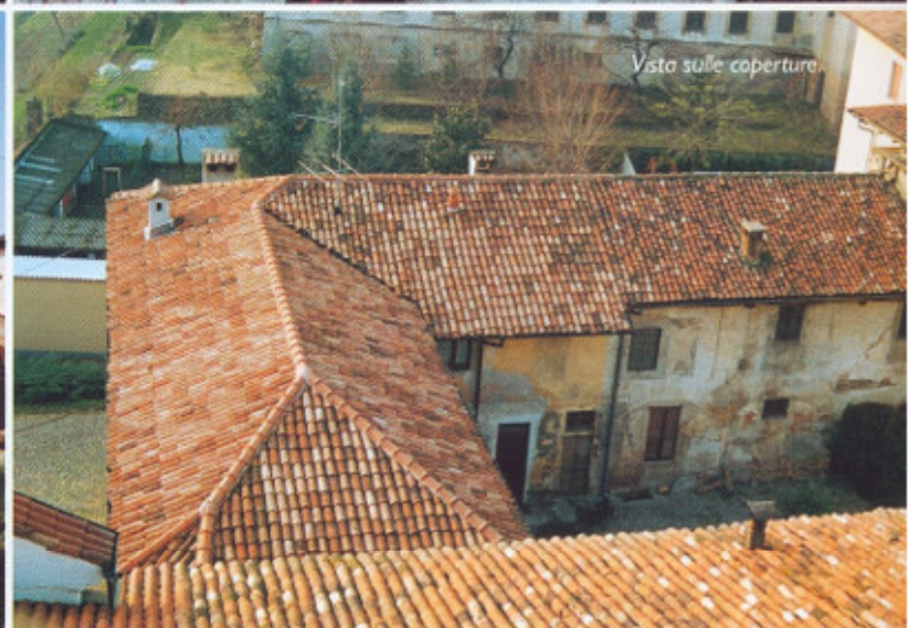
Intonaco scrostato e tracce di umidità sulle pareti.
