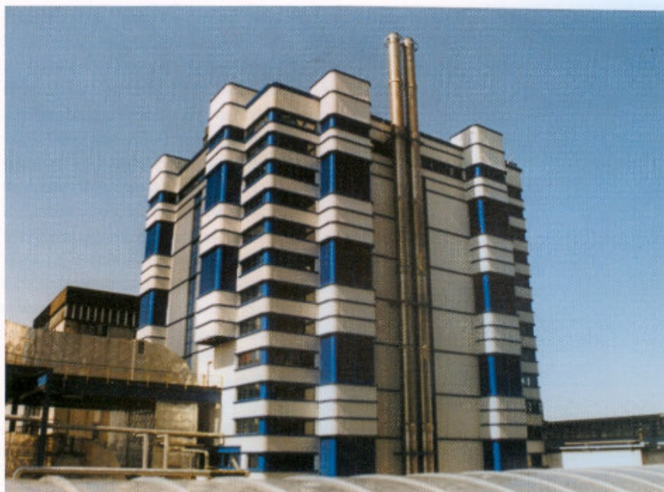
- Il prospetto est della caldaia TL2 -
