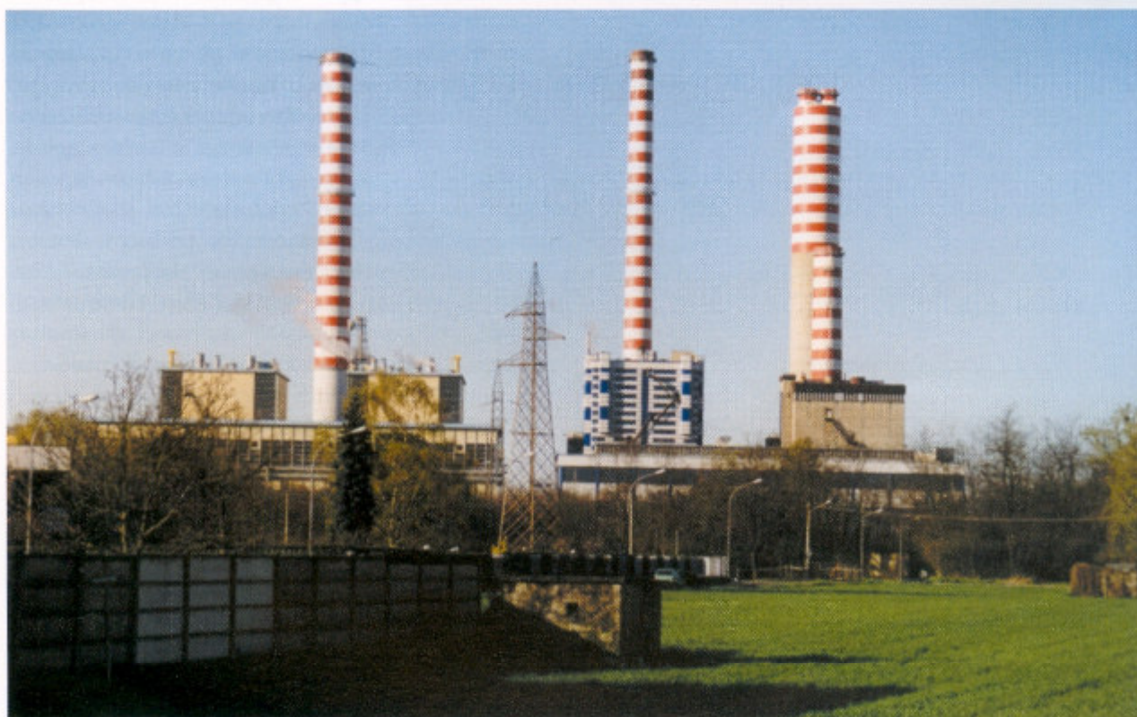
- I quattro gruppi caldaia della Centrale Termoelettrica di Turbigo: il terzo da sinistra (TL2) è rivestito con pannelli multistrato in alluminio -
